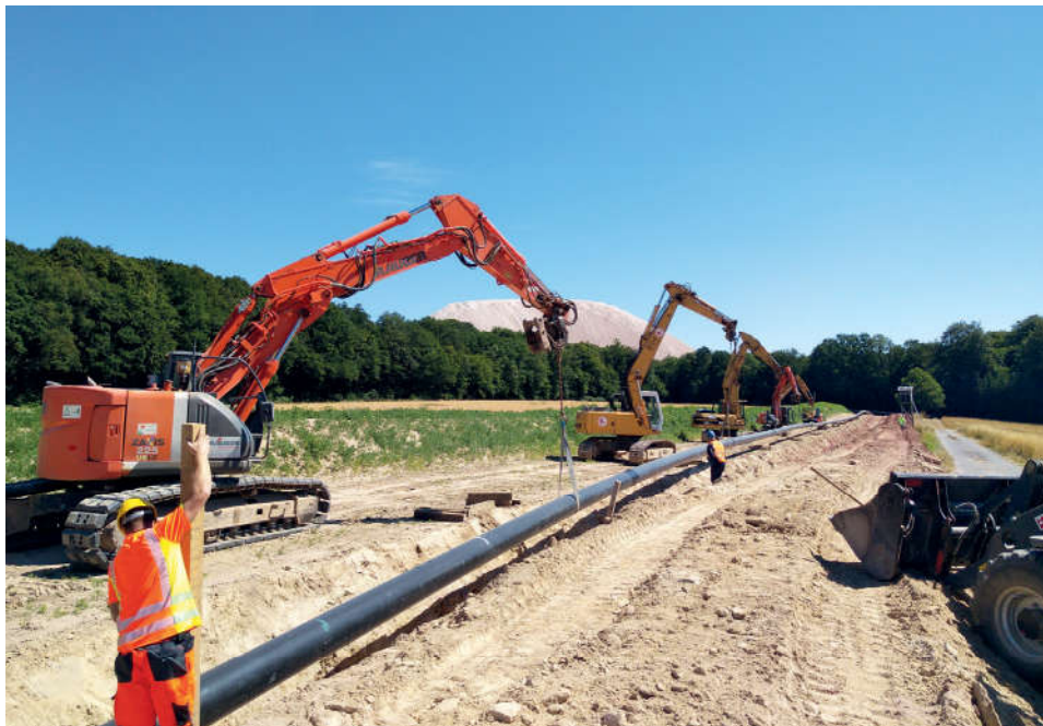
Kanalbau bei Ransbach: Eine schweißtreibende Aufgabe im Hitzesommer 2018.
