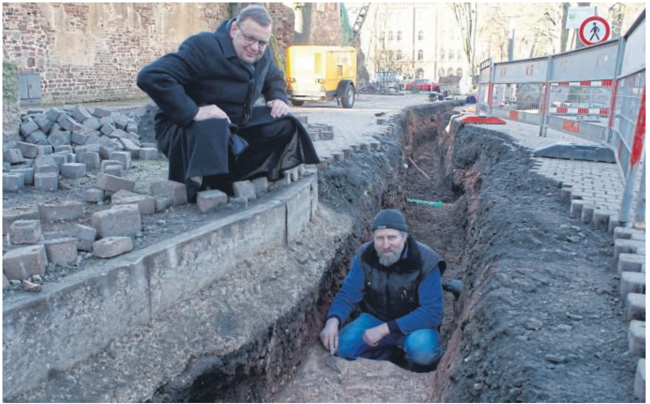
Alte Mauerreste wurden an der Nordseite der Stiftsruine bei den Bauarbeiten zur digitalen Ertüchtigung des Stiftsbezirks gefunden: Johannes van Horrick, Leiter Technische Verwaltung und auch für den Denkmalschutz zuständig, und der Archäologe Achim Boie (im Graben) schauen sich die historischen Überreste an.
