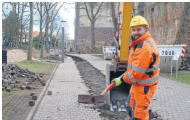
Konnten nach den Funden den Graben weiter ausheben: Baycan Sahin von der Firma Räuber und seine Kollegen. Die Verlegung der Rohre musste jedoch warten.
