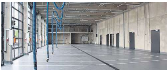
In die große Halle passen acht Einsatzfahrzeuge. Jeder Platz hat einen Abgasabsaugschlauch.
