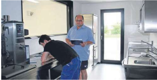
Baubahnme: Wehrführer Carsten Ullrich wirft in der Küche einen Blick auf die Messwerte von Tommy Röder von der Firma Hess.
