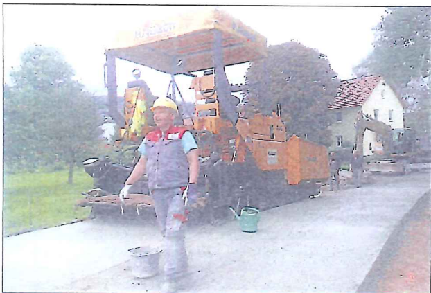
Flächenbeton an der Fahrzeugwaage Eichhof: Vorarbeiter Mark Weich legt letzte Hand an die Oberflächenveredelung.
